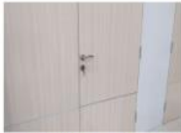
PEKERJAAN PINTU LIPAT AREA GUDANG
