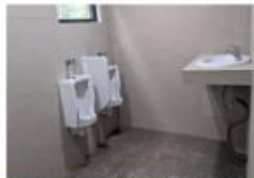
PEKERJAAN INSTALASI SANITARY TOILET PRIA
