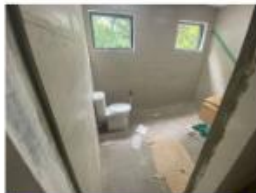
PEKERJAAN INSTALASI SANITARY TOILET PRIA
