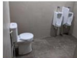
PEKERJAAN INSTALASI SANITARY TOILET PRIA
