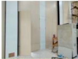
PEKERJAAN PINTU LIPAT AREA GUDANG
