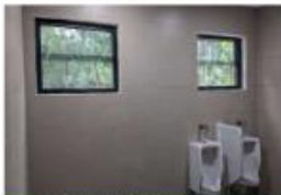
PEKERJAAN INSTALASI SANITARY TOILET PRIA
