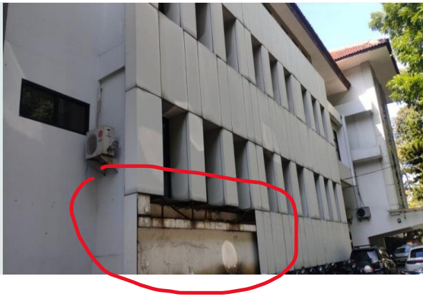
Bangunan gedung sebelum di perbaiki
