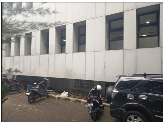
Bangunan Gedung setelah di perbaiki
