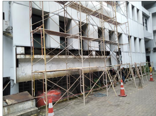
Bangunan gedung sedang di perbaiki
