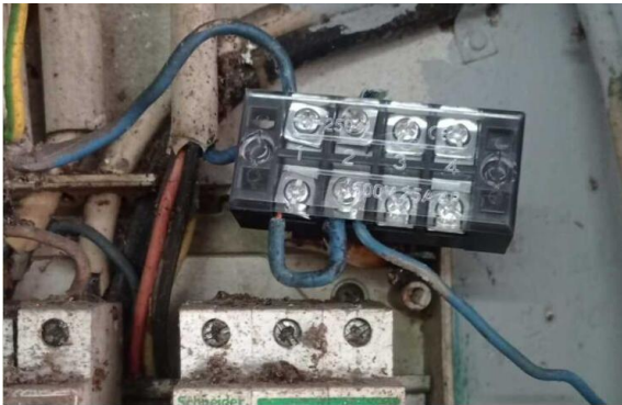
Penggantian NCB Kantin
